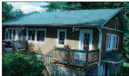
ACCÈS AU LAC CONNELLY À 2 PAS! Plain-pied 3 cac avec s-sol fini, rénové de A à Z. 184 000 $
